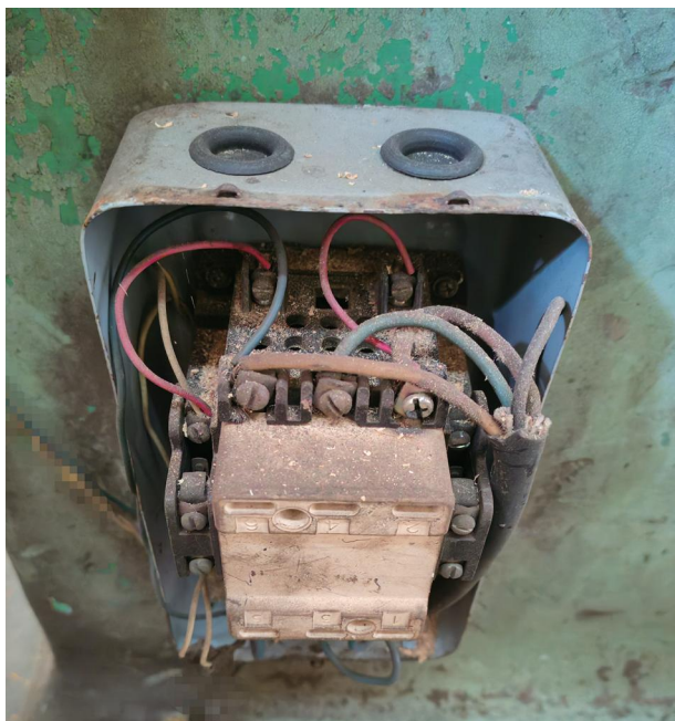
石家庄某化工企业一设备电源接线盒缺失防护盖，检查人员发现后立即进行了整改。 田园 摄
