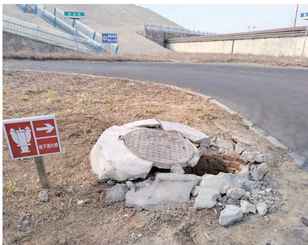
邢台市某企业地下消火栓损坏，企业发现后及时进行了修理。 何卫东 摄
