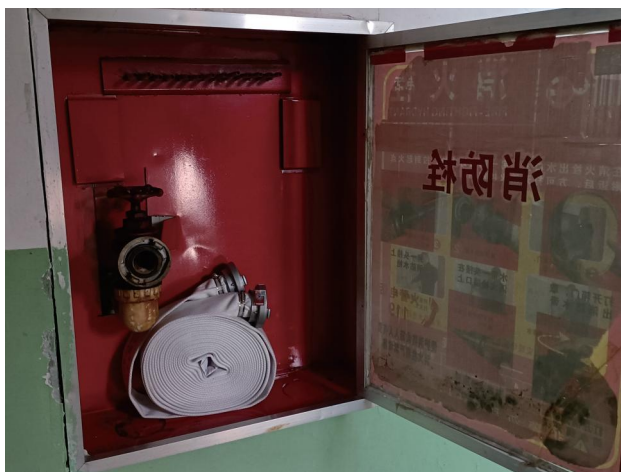
邯郸市某单位消防栓缺少水枪头，检查发现后，及时配齐了设备。 吴俊平 摄
